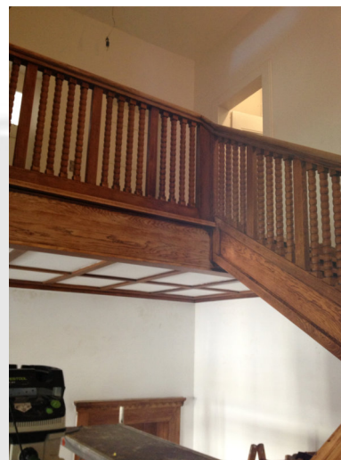
Aufarbeitung historische Holztreppe
