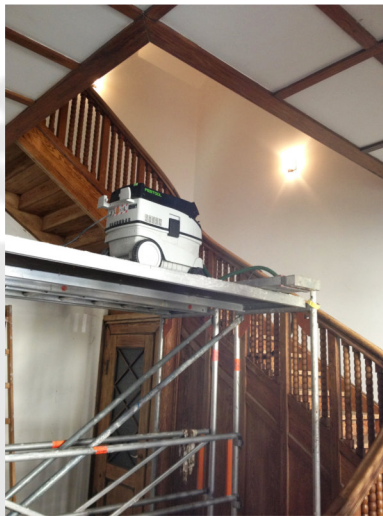
Aufarbeitung historische Holztreppe
